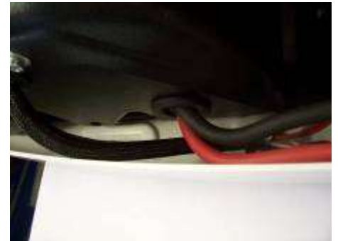
3. Faire passer les câbles par le trou, les faire sortir à l'intérieur de la cabine par la reprise d'air, et remettre le passe-fil en place. S'assurer de l'étanchéité du passe-fil
