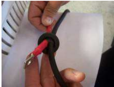
2. Passer les deux câbles dans le passe fil percé de deux trous
